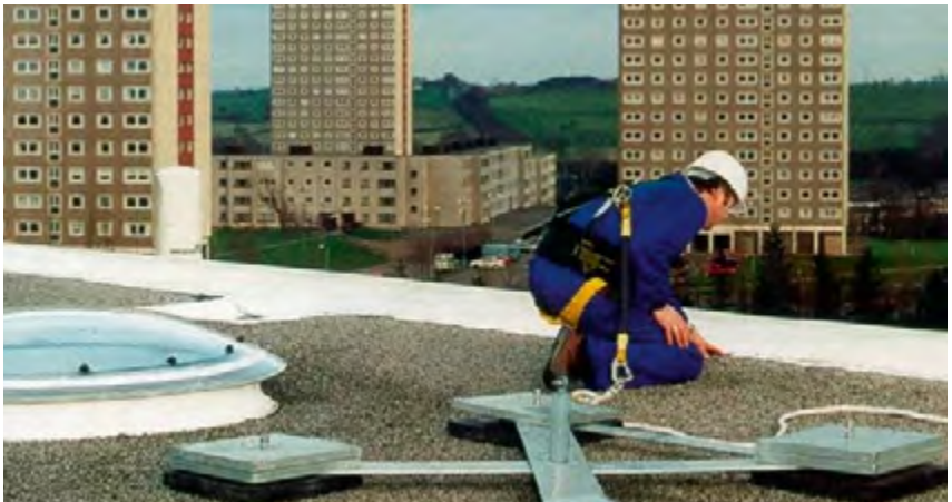
Bild 32: Durch Eigengewicht gehaltene Anschlageinrichtung (z.B. Betongewichte)
