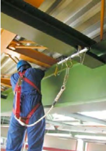
Bild 8: Beispiel eines Auffangsystems mit Falldämpfer
